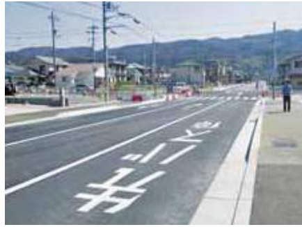
② (一)平群信貴山線 吉新工区 [平成29年4月開通]
