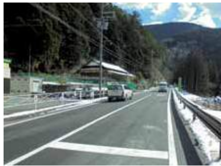
⑧ (一)大又小川線 三尾工区 [平成29年10月開通]
