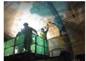
▲トンネルの点検状況
